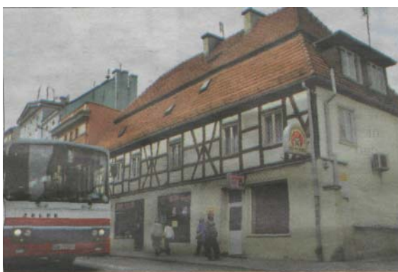
Kamienica z muru pruskiego przy ul. Średzkiej
